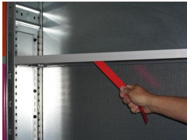
6. Schiene auf ganzer Länge während mehrerer Sekunden **mit ca. 5 kg andrücken**. Türen erst nach 72 Stunden, beziehungsweise 3 Tagen einhängen. **Nur dann kann das Montageband die volle Klebekraft entfalten!**
