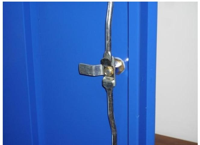
8. Türen ausrichten durch Unterlegen der Regalpfiler. Wichtig für einwandfreie Funktion des Stangenverschlusses!
