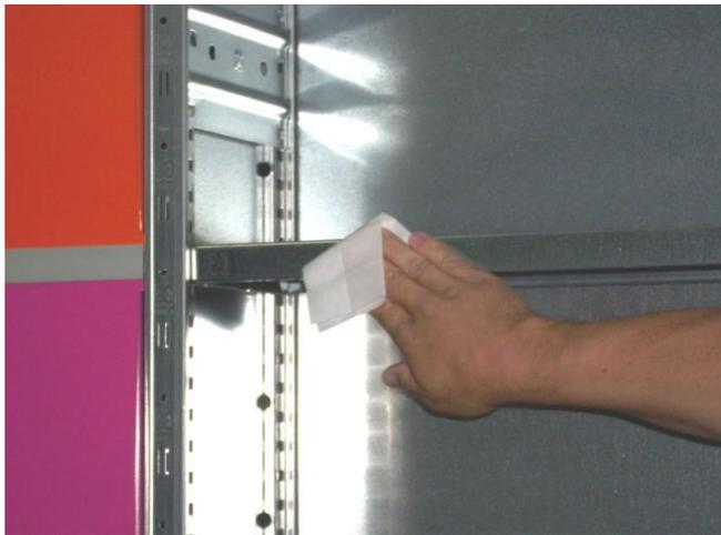
4. Schiene am Tablar ausrichten und an beiden Enden aufs Tablar drücken.
