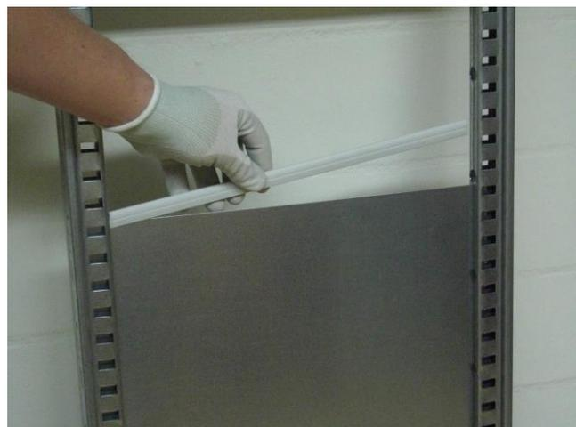
2. Nächstes Element von oben in Plastikprofil stecken.
