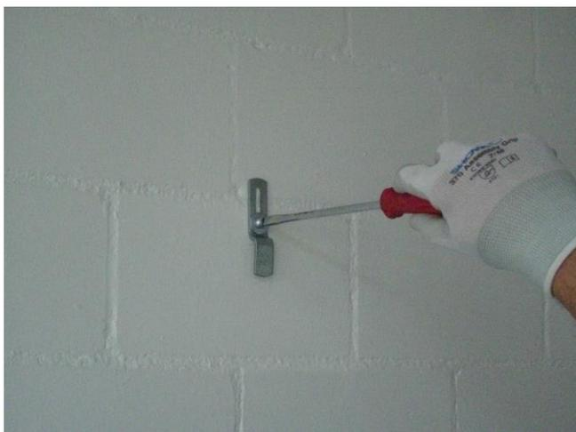
4. Regal an die Wand stellen und Wandbefestigung von oben in den Pfeiler schieben. Schraube fest anziehen. Der Pfeiler selbst wird nicht mit der Wandbefestigung verschraubt.
