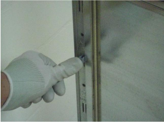
„Bei zugeschnittenen Pfeilern beachten: Sollen die Rückwände mit den Pfeilern oben bündig abschliessen, muss der Schnitt durch das Loch verlaufen, bzw. das nächste Loch muss sich 100 mm unterhalb vom Pfeilerende befinden.“
